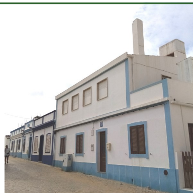
Destruição e platibanda e acréscimo de um piso Foto CIIPC, 2020
