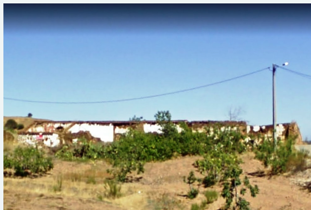
Ruina onde se rezava o terço no Monte do Ribeiro
