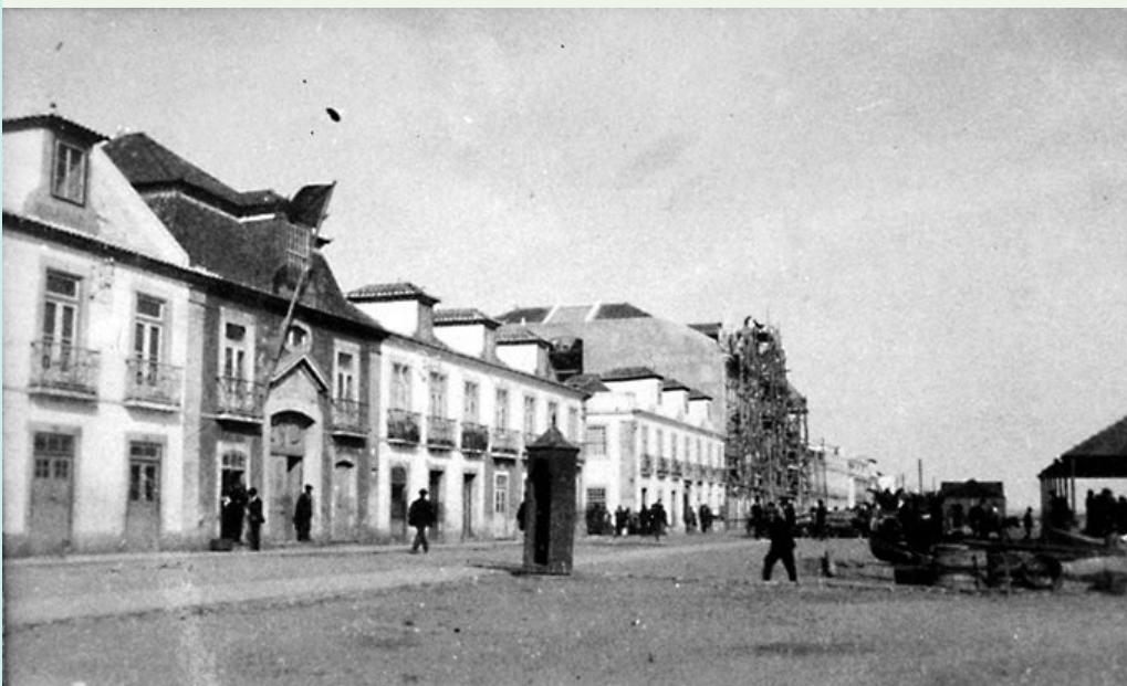
Avenida da República (Antiga avenida D. Amélia) com a construção do Hotel Guadiana
